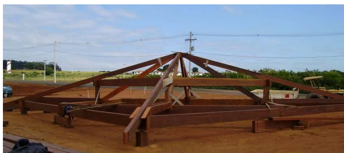
Fig. 7 – Foto da montagem do telhado Fonte: fornecida pelo arquiteto
