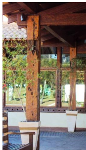
Fig.4 – Detalhes dos pilares reutilizados – Fonte: autor
