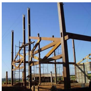
Fig. 6 – Foto da montagem da estrutura Fonte: fornecida pelo arquiteto
