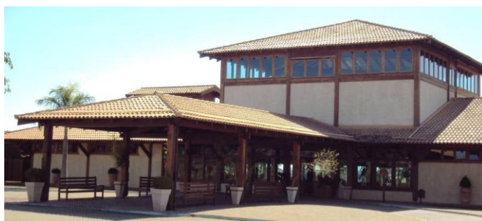
Fig. 2 – Fachada frontal do clube de Golfe – Fonte: autor
